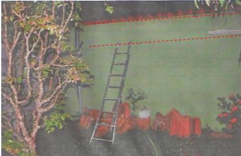
FOTO 147: Escada apoiada na parede anterior à esquerda do lote
